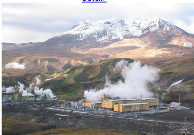
Рис. 22. Мутновская геотермальная электростанция http://www.tpe.ru/pages/objects/geotpp/mutnovskaya-geoes/
